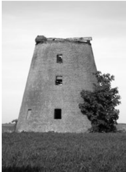
Budzisz – pozostałości wiatraka, fot. A. Langowski
