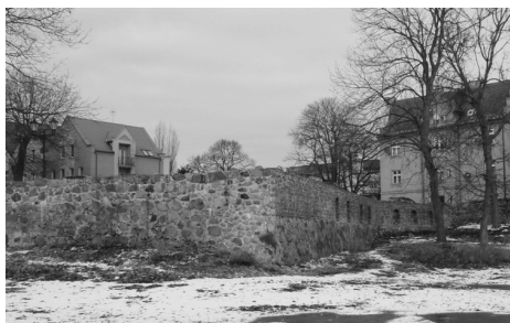
Zniszczone mury w Sztumie, fot. P. Głogowski
