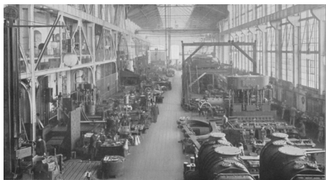
Maschinen-Montagehalle von F. Schichau, Elbląg
