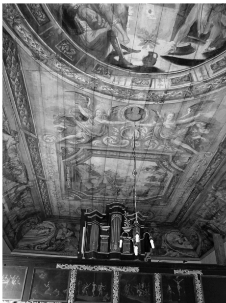
Odrestaurowane wnętrze kościoła, fot. A. Czapliński
