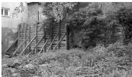
Zabezpieczony fragment muru w Sztumie, fot. P. Głogowski
