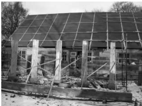
Budowa domu w Cyganku. (fot. M. Opitz)
