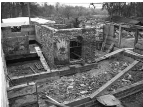
Przenosiny domu podcieniowego do Cyganka - budowa fundamentów. (fot. M. Opitz)
